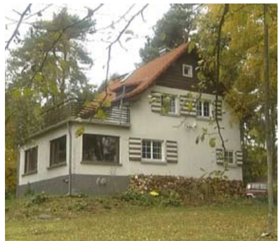
Öko-Förster Wohlleben berät die Pellet-Heizung seines Häuschens
